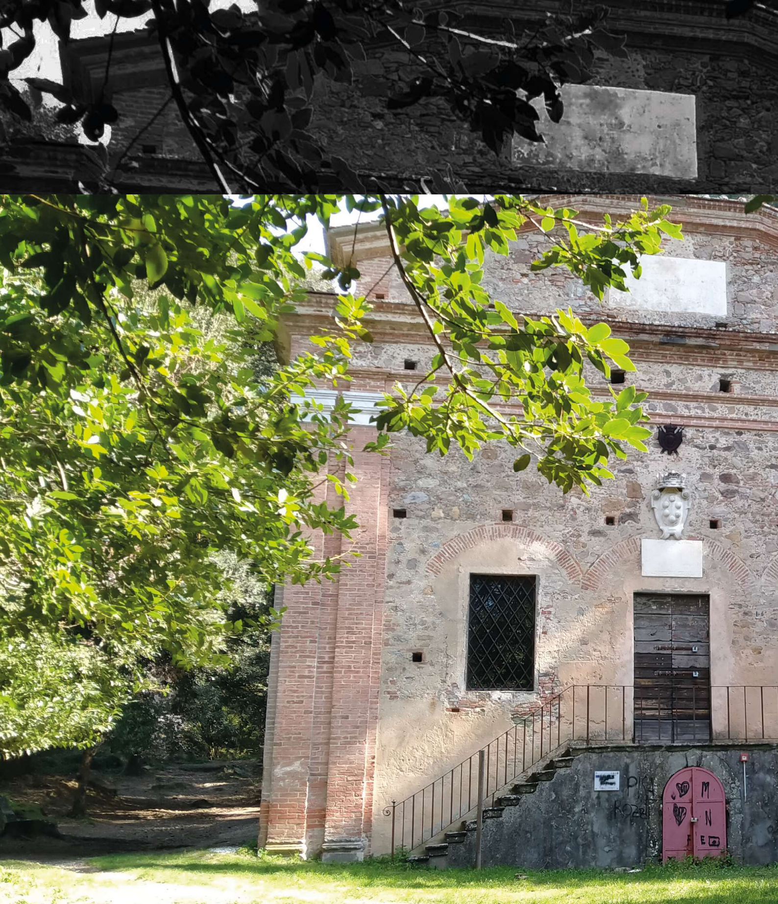
Acquedotto Mediceo Asciano, località Il Cisternone Il Cisternone o Conserva Grande Foto: A. Pierotti
