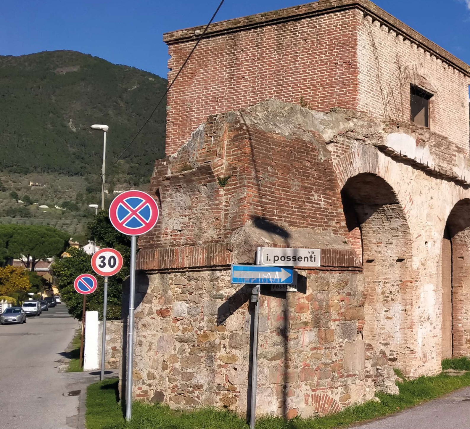
Acquedotto Mediceo Asciano, fonte Foto: A. Pierotti
