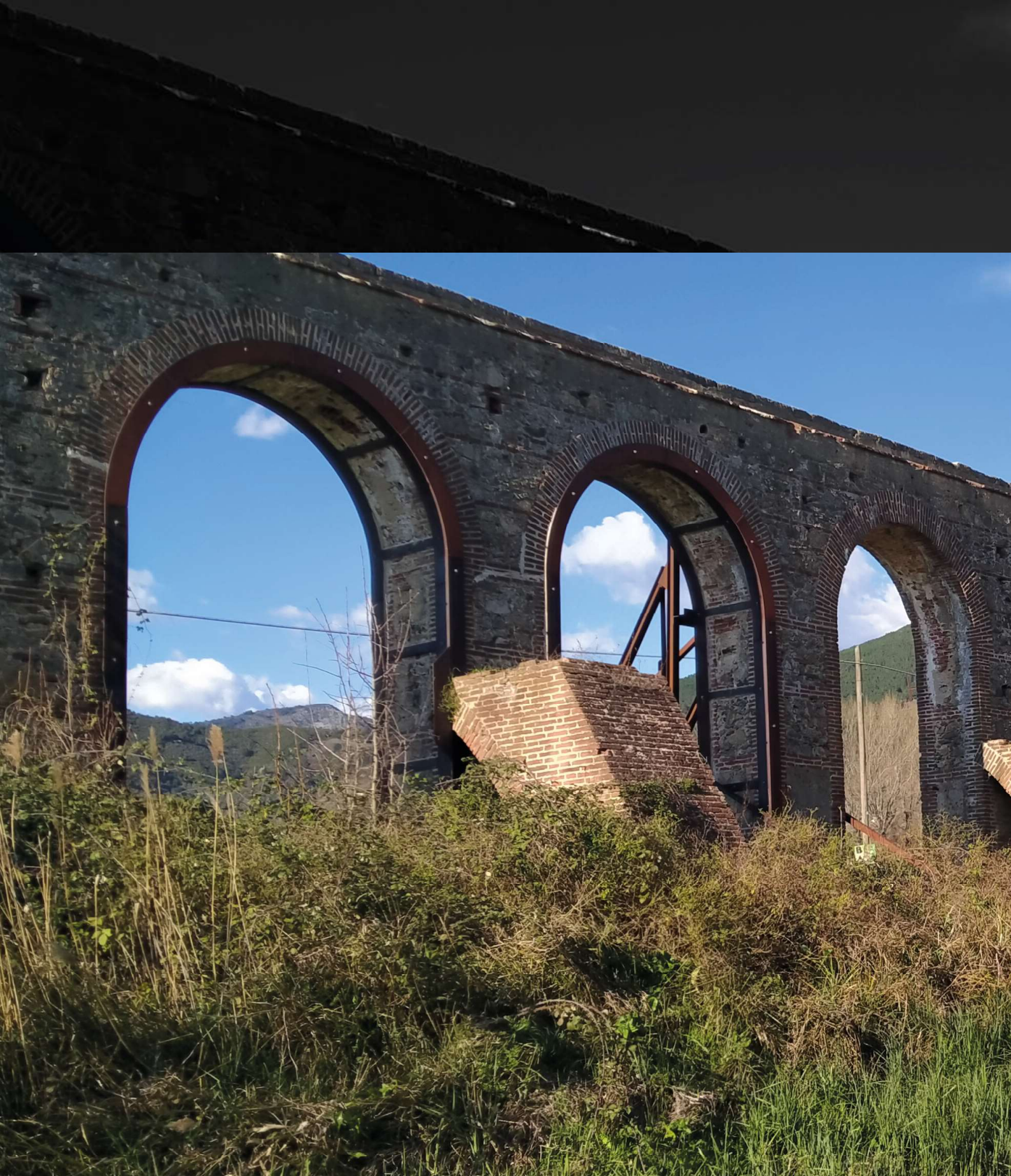
Acquedotto Mediceo Asciano, via Vecchia dei Condotti Archi sostenuti da contrafforti ( vedi testo ) Foto: A. Pierotti
